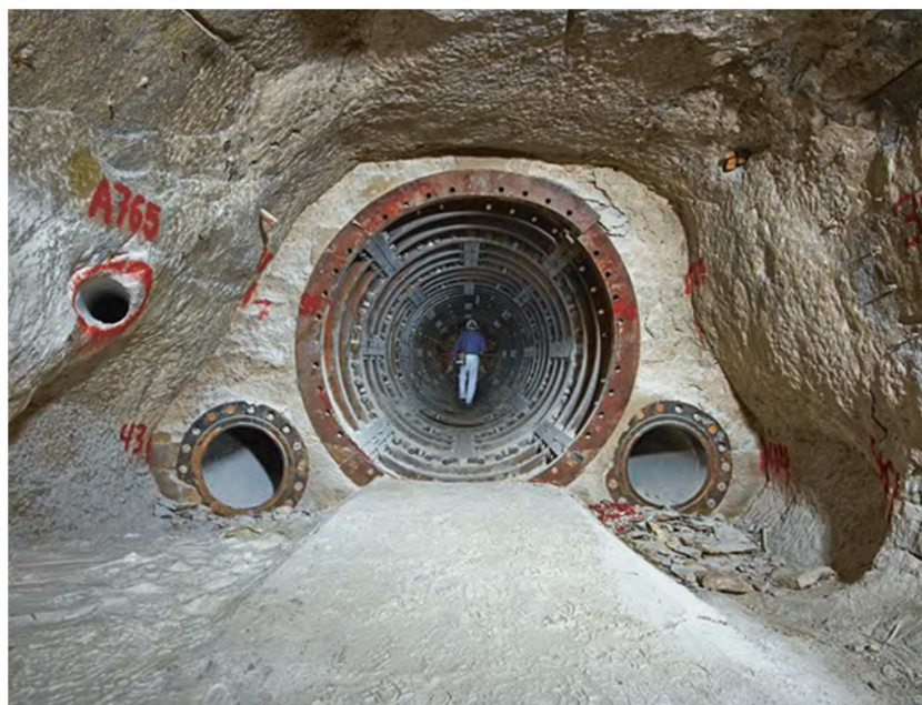
Abb. 25 Foto des Dammjochs auf der 700-m-Sohle der Schachtanlage Asse II, Foto von Janosch Gruschczyk [BfS 2014].
